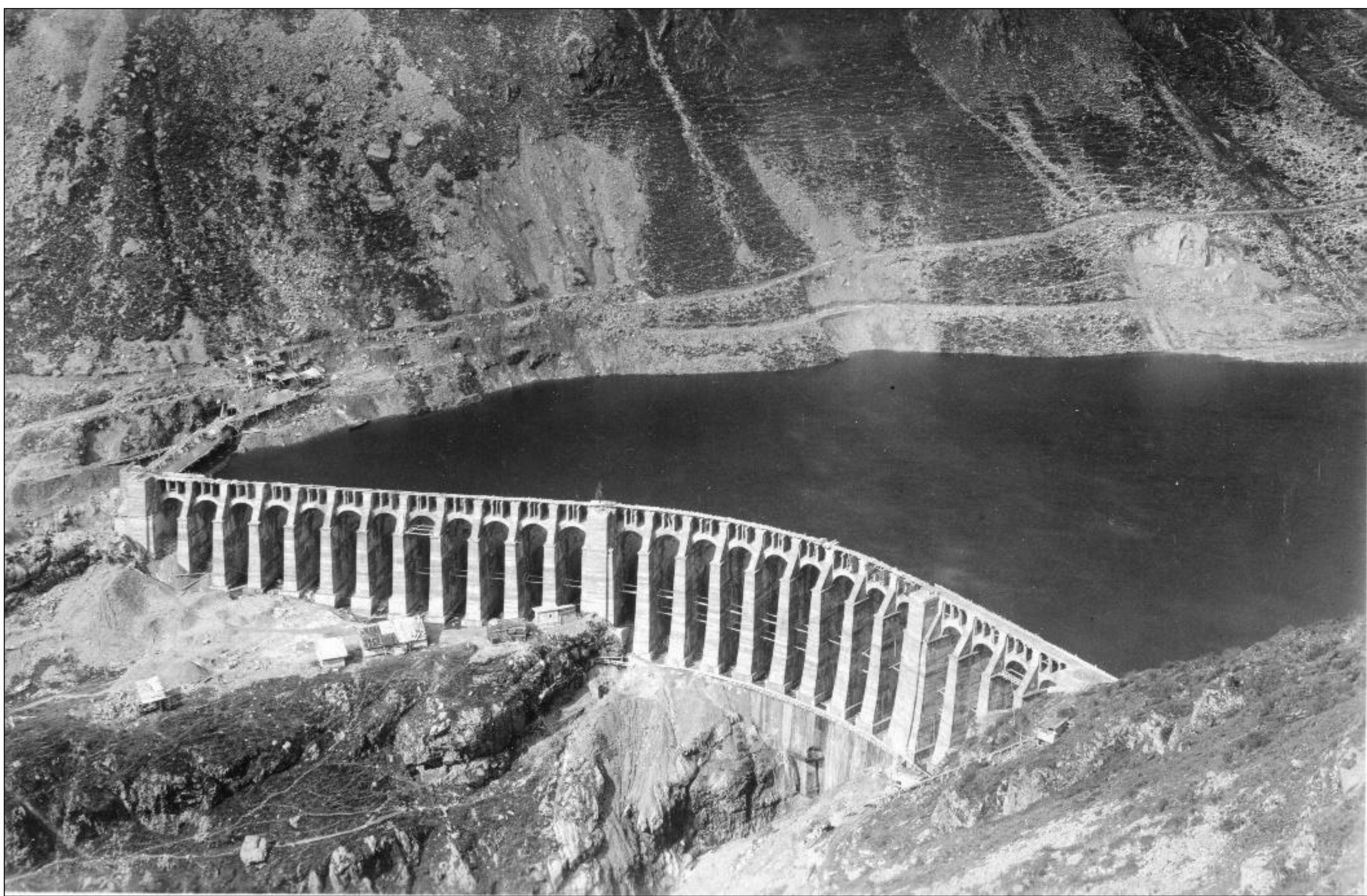
La diga terminata (per gentile concessione di Archivio Ing. Conti)
