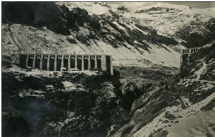
Fig. 43 – La diga e lo squarcio (per gentile concessione di Archivio MEta Ardesio)
