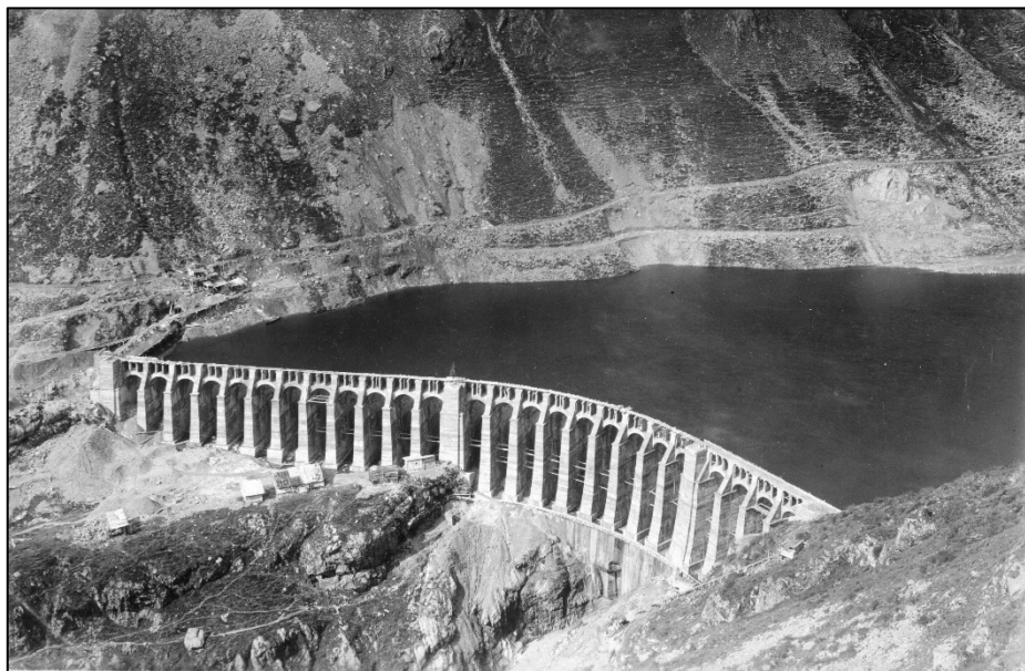
Fig. 33 – La diga terminata (per gentile concessione di Archivio Ing. Conti)
